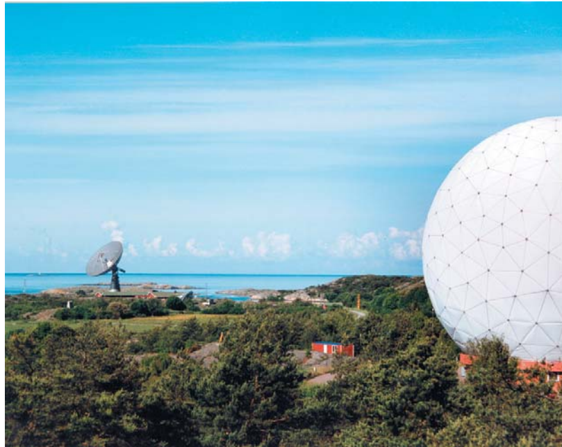
Observatoriet på Råö med två av de moderna antennerna. Den vänstra har en diameter på 25,6 meter medan det högra, som är skyddad för väder och vind av en radom, har en diameter på 20 meter. Den första antennen är känslig för radiovågor i cm-området medan den andra är känslig för radiovågor i mm-området. Foto: Bert Hansson.
