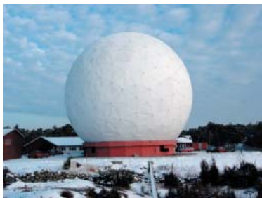
Fig. 2. Astronomer från hela världen använder Onsala rymdobservatoriums 20,1-meterteleskop. Det invigdes 1976 för observationer av centimeter- och millimeterlånga radiovågor. Teleskopet är skyddat för väder och vind av radomen. I ungefär 10 år var detta världens största teleskop för observationer av millimetervågor, och det spelar fortfarande en viktig roll inom radioastronomin.
