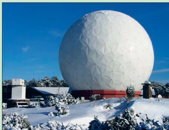
Bild 1: Onsala rymdobservatorium. I mitten på bilden syns det radominneslutna 20-metersteleskopet, vilket huvudsakligen används för radioastronomisk forskning, där frekvenser upp till strax över 100 GHz tas emot med en god verkningsgrad. Teleskopet används också för geodetisk VLBI, då det samtidigt tar emot signaler från de mest avlägsna galaxerna vid frekvenser omkring 2,3 och 8,4 GHz (S- och X-band). I förgrunden till vänster står en mikrovågsradiometer, vars uppgift är att mäta den termiska strålningen från vår atmosfär, och utgående från dessa data kan mängden vattenånga och flytande vatten (moln) beräknas i mättriaktionen. GPS-antennen syns just till höger om radomen (se också Bild 3).
