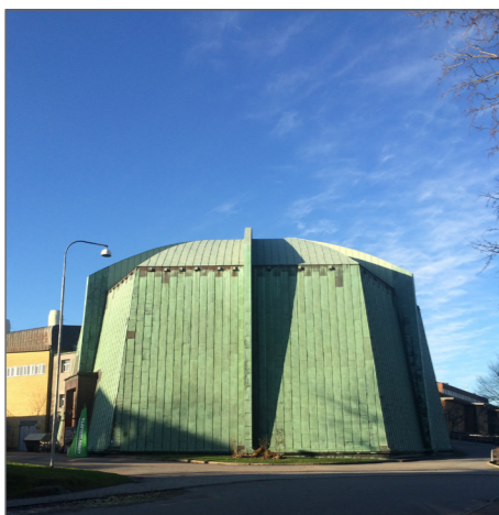
KOPPARBUNKERN GRÖN KOPPAR
